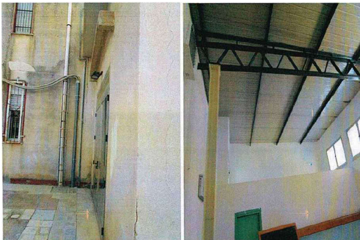
Particolare del corpo palestra
